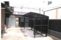
土間コンクリートも打ちました。工事後
